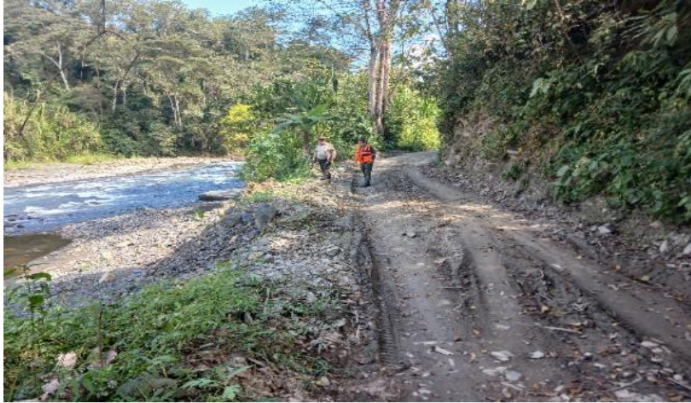
FOTO N°03: SE MUESTRA LA MÁRGEN DERECHA DEL RIO CHIRUMBIA, CARRETERA EXPUESTA, REQUIERE CONFORMACIÓN DE BORDOS.
